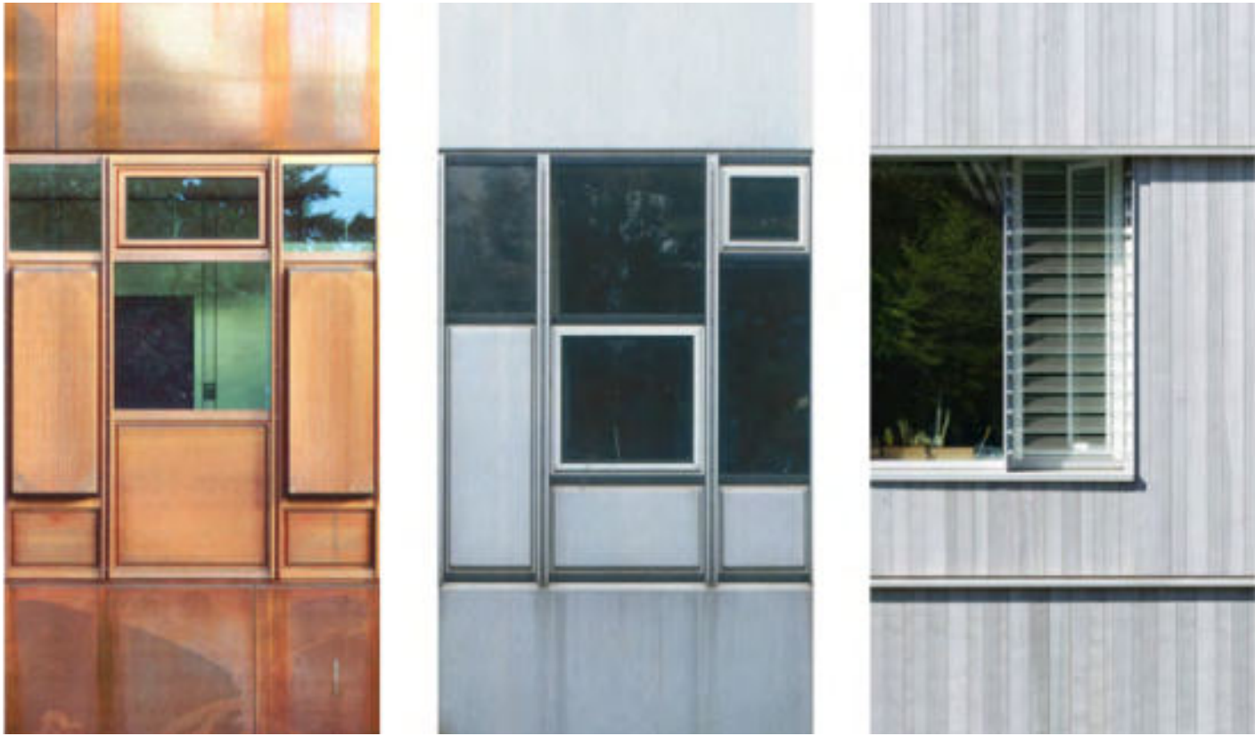
115: „Rostlaube“ „Silberlaube“ „Holzlaube“ http://www.nagler-architekten.de/projekt-daten/projekt-ansicht/3-bauabschnitt-fu-berlin/ (Abrufdatum 25.09.2017)
