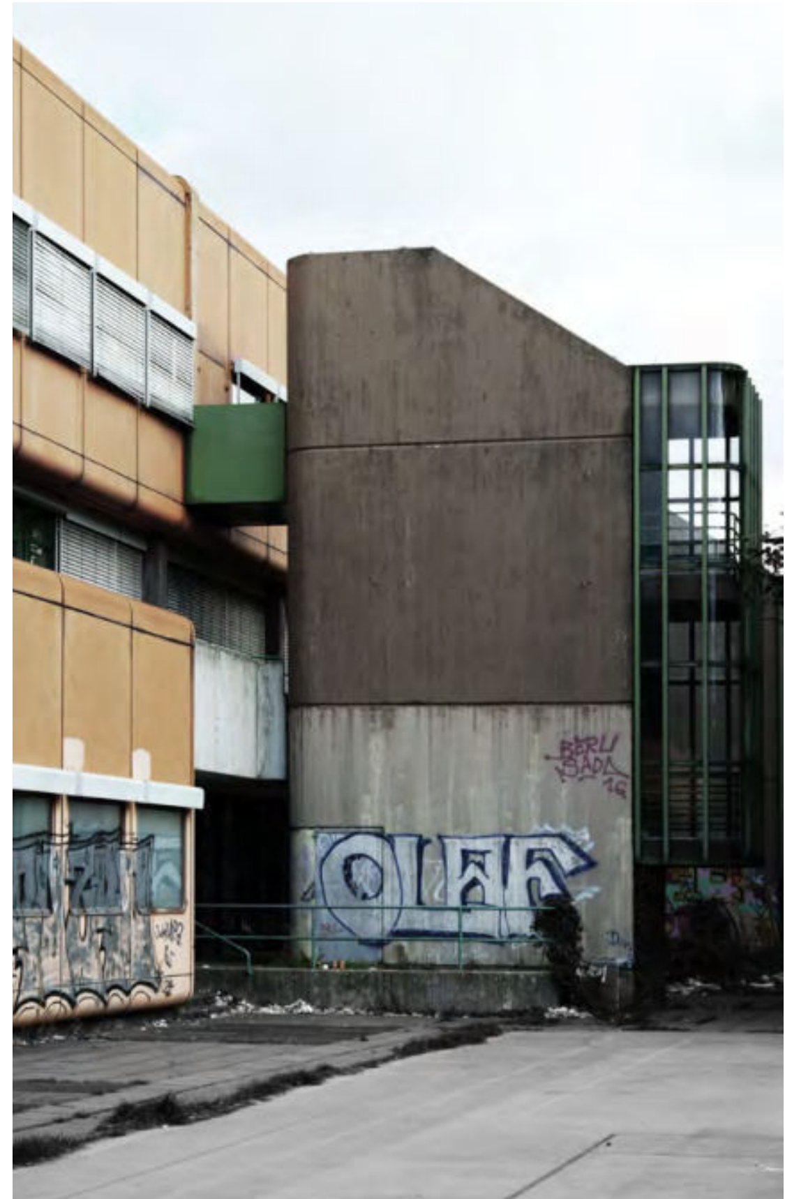
68: Außenliegender Treppenturm Tim Wittwer und Jens Müller
