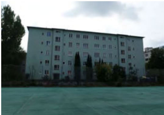
84: Nordfassade des Hauses südlich des Sportplatzes Tim Wittwer und Jens Müller
