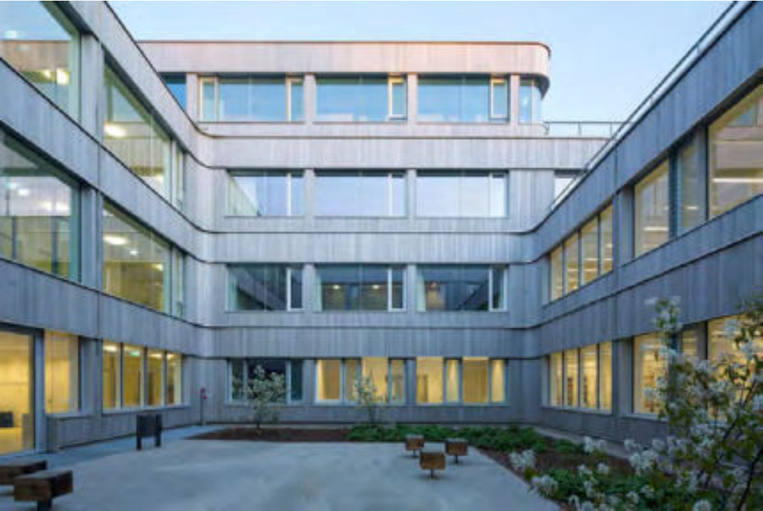
114: Hofbereich der „Holzlaube“ http://www.nagler-architekten.de/projekt-daten/projekt-ansicht/3-bauabschnitt-fu-berlin/ (Abrufdatum 25.09.2017)
